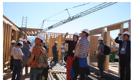
목구조 건축 현장을 견학중인 참가자들
